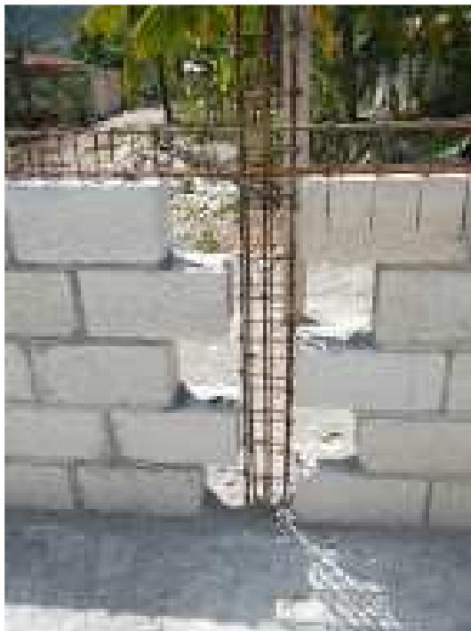
Photo 1 Harpage maçonnerie chainée
