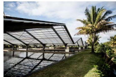
Ranskalaisyritys Akvo Energyn aurinkopaneelit tuottavat sähköä ja varjostavat kalaviljelyalaita L'Étang-Salén kaupungissa Ranskassa. Kuva: STELLA PICTURES / ddp / ADP
